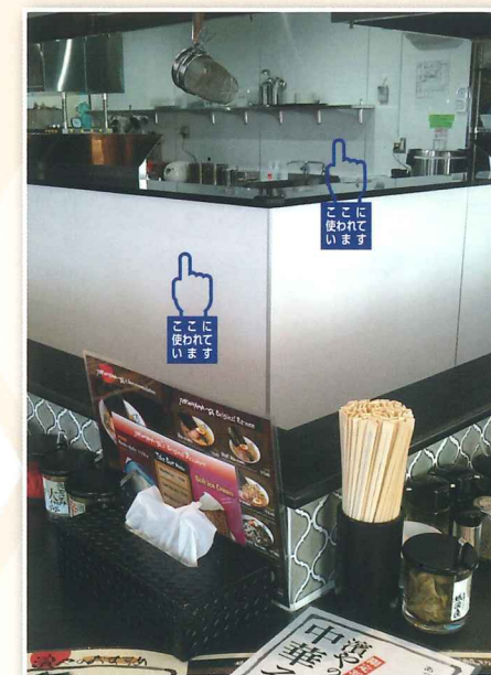
▲厨房内壁パネル
