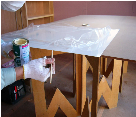
(錆止め塗料塗布)端部全てに塗ります
