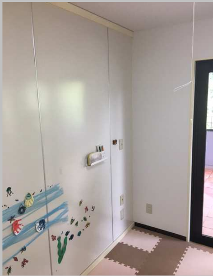
保育施設内壁
